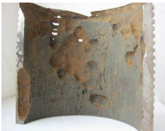
Рисунок 3.9 – Вид внутрішньої поверхні зруйнованого різьбового з'єднання
