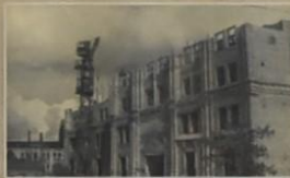
Реконструкція будівлі лабораторного корпусу, 1954 р.
