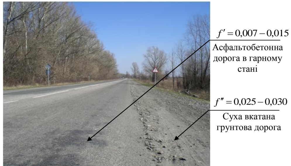
Рис. 2. Ділянка окружної дороги м. Харкова з різними значеннями коефіцієнту опору коченню f' і f''
