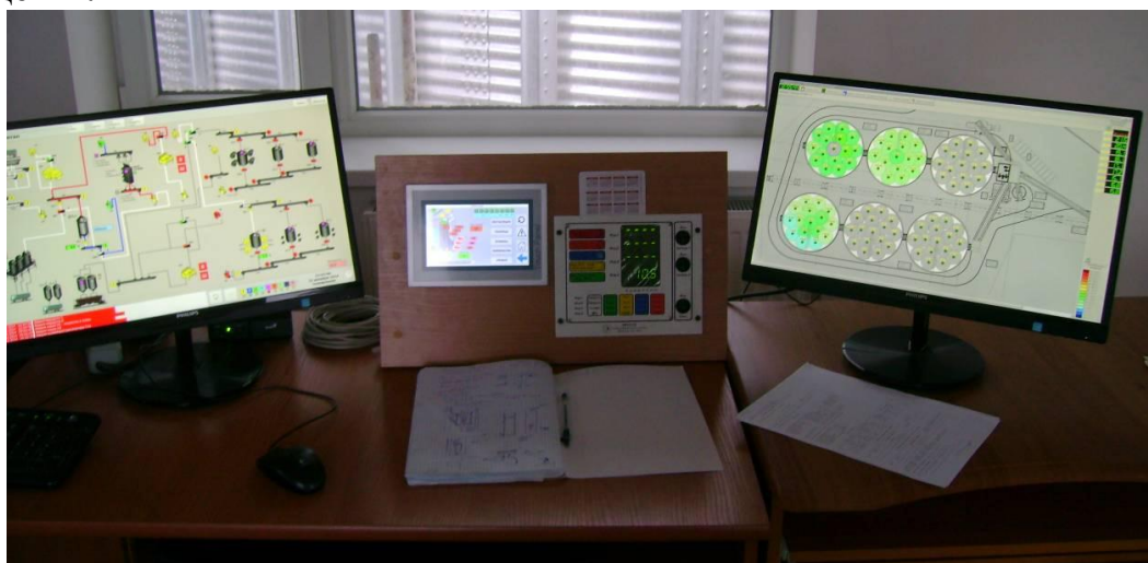
Рис. 3 – Пульт управління зерносушаркою
